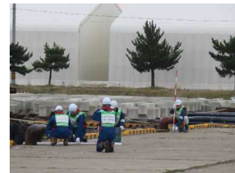
【係留施設点検】
