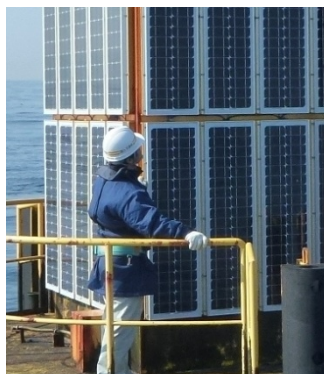
パネル交換後の確認状況（4月23日）
